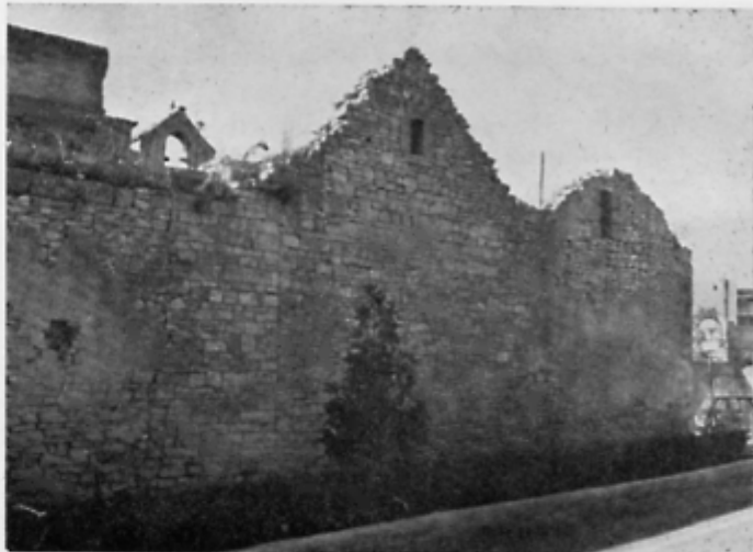
Fig. 4 S. Maria di Modugno. Muratura del lato posteriore orientale.
