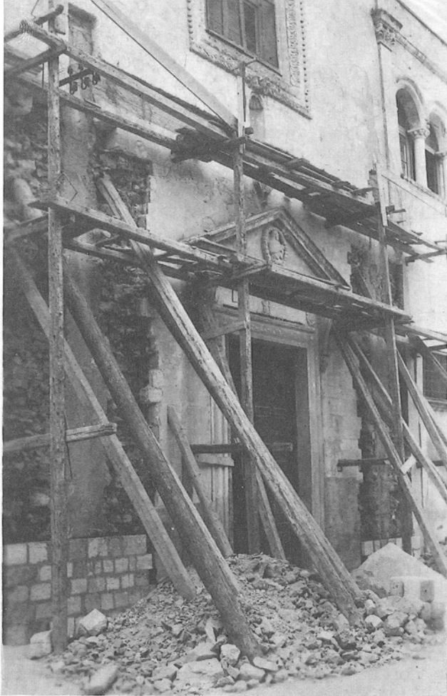
La facciata della chiesa di S. Agostino durante i lavori di restauro del 1951
