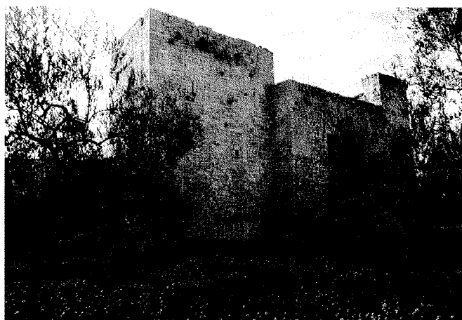
Balsignano: le mura perimetrali del castello.
