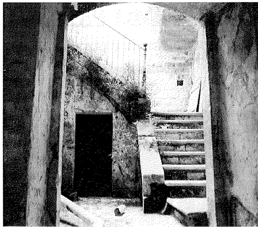
L'ingresso al palazzo su via V. C. Perrone.
