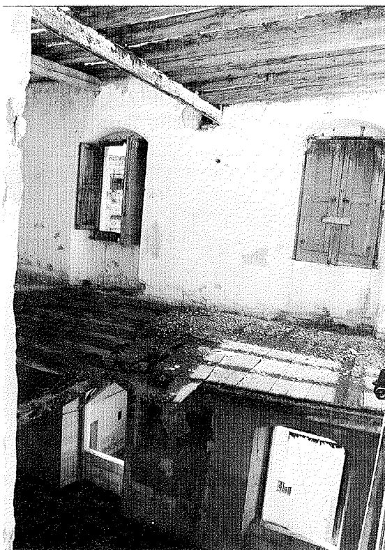
I resti del solaio di calpestio e della copertura lignea della sala adibita dopo il 1837 alle sedute decurionali
