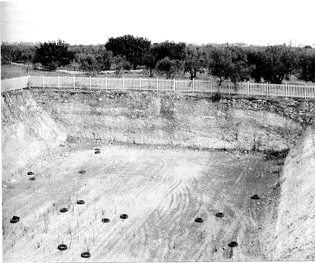
Particolare della parte terminale della trincea della tratta Bitetto-Modugno che, come previsto dal progetto del 1989, è concepita per giungere completamente interrata nei pressi del passaggio a livello della via di Bitonto (foto M. Caporusso)
