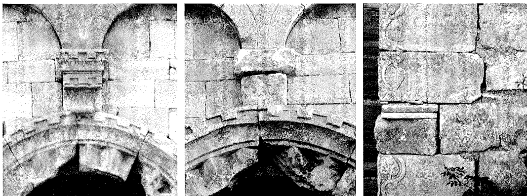
A sinistra una foto degli anni Settanta del capitello che sorreggeva il portale della chiesa di San Felice; al centro, una recente foto dopo il furto negli anni Ottanta del capitello sostituito con pietre appena sgrossate; a destra, particolare del portale interno di accesso alla corte del castello che risulta privo di un concio calcareo scolpito con motivi floreali, divelto e rubato nel 1988
