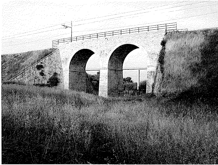
Un tratto di Lama Lamasinata nei pressi del Boschetto col ponte del tratto ferroviario Modugno-Bitetto
