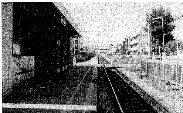
La stazione delle F.S. di Modugno, ridotta ad un rudere
