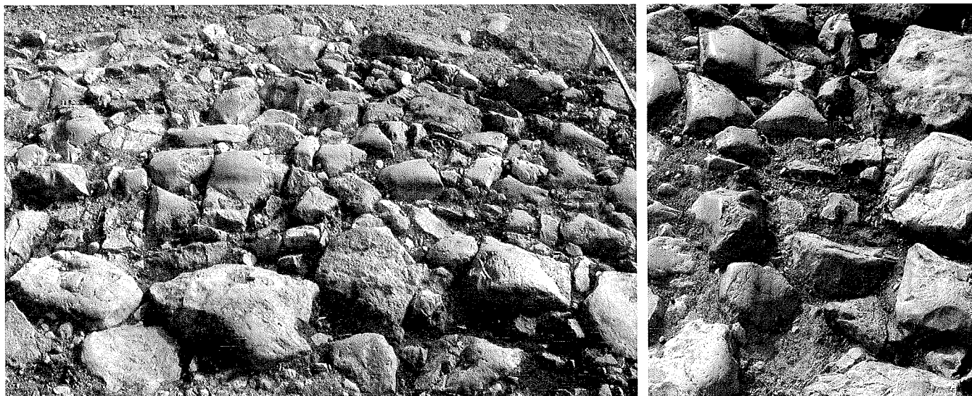
3 (a sinistra). - Particolare del pavementum: in primo piano la doppia fila di umbones e, parallelamente ad essa, le tracce del solco carraio; 4. (a destra) - Particolare dell'azione dell'usura sul basolato: in alto a sinistra le tracce di un solco; al centro dell'immagine la lacuna lasciata dallo stacco di alcuni blocchi del pavementum con successivo riempimento di piccoli ciottoli.
