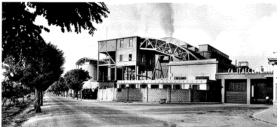
La cementeria sulla via di Bitetto, per la quale si impone la bonifica non solo perché vi sono coperture e strutture in amianto, ma anche per la produzione di cemento amianto che in quell'impianto è stato realizzato per molti decenni. Ultimamente si è costituita nella città un'associazione di cittadini che ha riproposto il problema della bonifica della cementeria, questa sorta di Fibronit modugnese.
