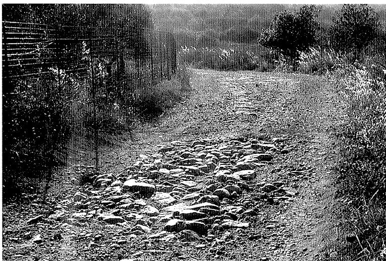
Fig. 6. Misciano: basolato inerente al percorso di una viabilità antica.
