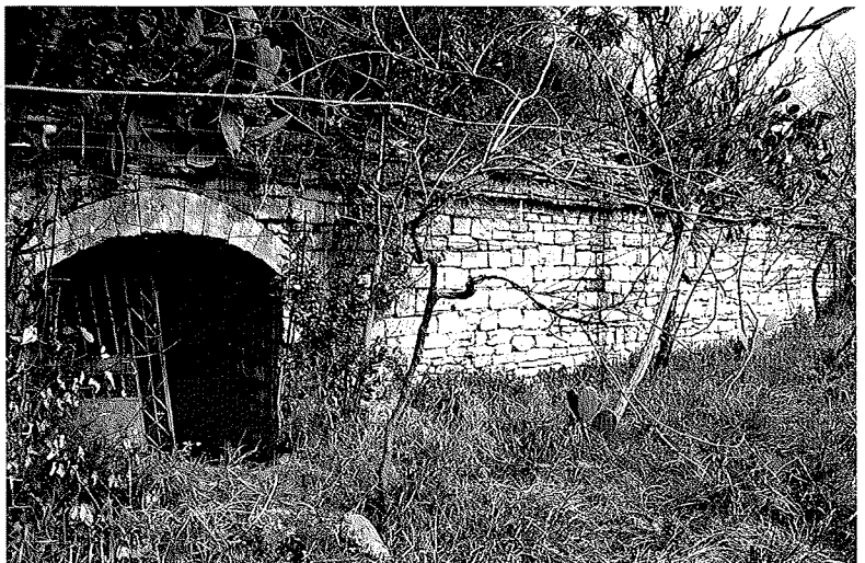
Fig 8. Misciano: costruzione medievale di calcare locale in opera quadrata.
