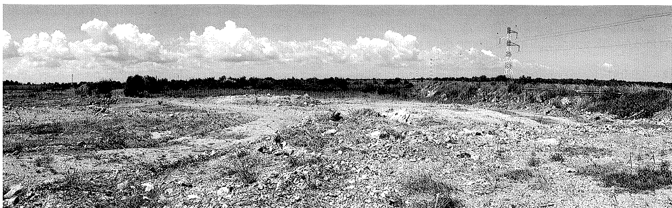
Misciano: area interessata dall'insediamento del termovalorizzatore; nella foto, che risale a luglio, sono visibili le zone spianate per effetto dei lavori già avviati in giugno (foto R. Sanseverino).
