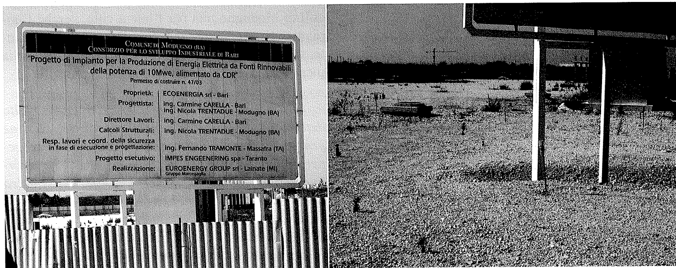
Modugno, Via Fiordalisi (Zona ASI): l'area dell'inceneritore con il cartello dei dati progettuali
