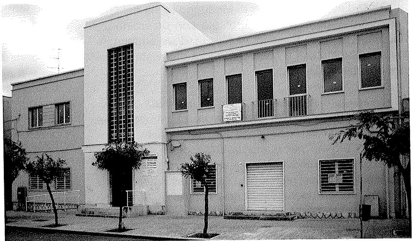
Il complesso dell'Oratorio, che sarà la nuova sede del SIM (foto Lello Nuzzi)
