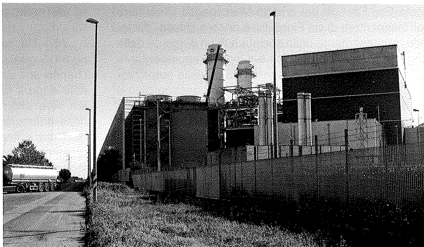
La centrale turbogas di Sorgenia
