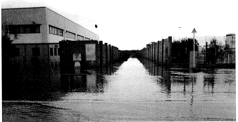
Allagamenti in zona Misciano (foto Nicola De Toma)
