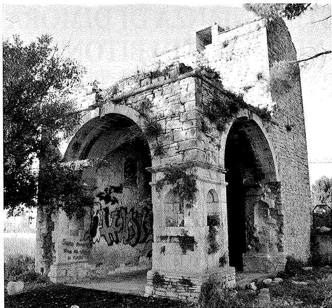
Portico addossato alla torre di avvistamento
