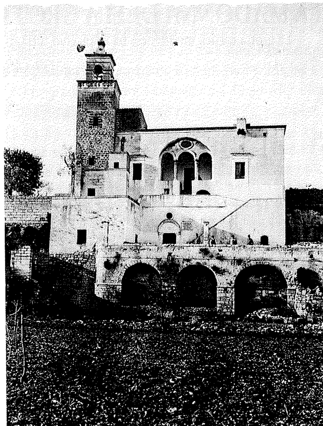
FIG. 1 - Il santuario di S. Maria ad cryptam a Modugno (foto 1910). Al di sopra delle arcate, che poggiano sul ciglio della lama, e dietro il parapetto, si intravede la porta di ingresso alla grotta
